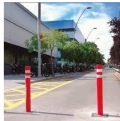
Figura 3. Fita de protecció mecànica
